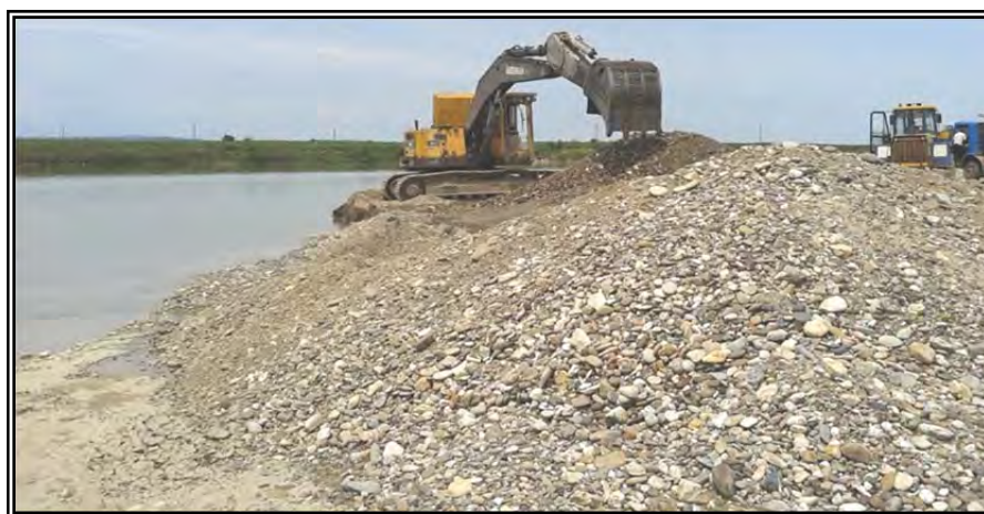
Figura 13-3. Excavator în plin proces de exploatare.
